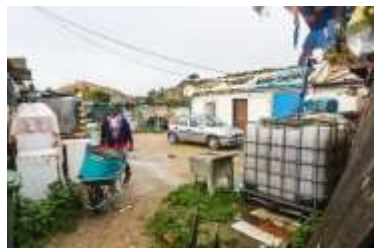
11 | Condições das construções precárias das Terras da Costa
