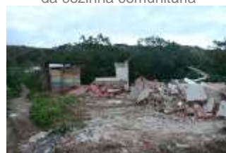
17 | Demolição do núcleo junto à Rua do Juncal
