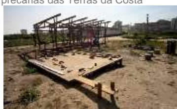
14 | Construção do primeiro módulo da cozinha comunitária
