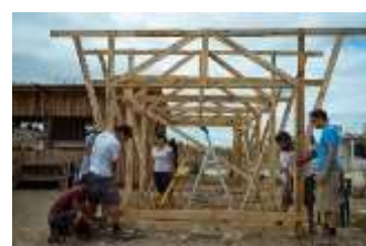
15 | Construção do segundo módulo da cozinha comunitária
